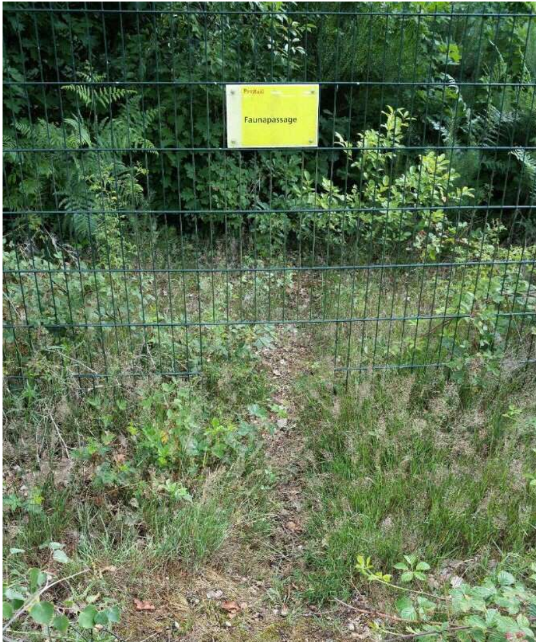
Figuur 4. Voorbeeld van een faunapassage in een hekwerk; afmeting 20 cm x 20 cm (Prorail)
